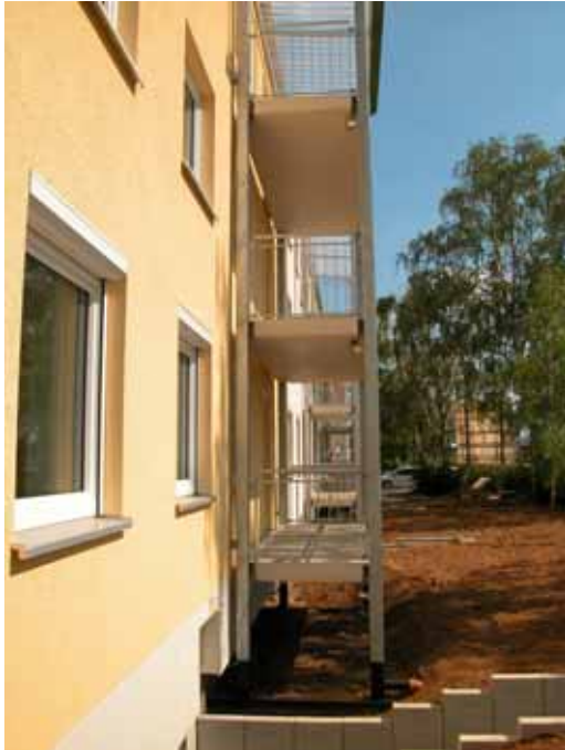
Obr. 9: Oddělená konstrukce balkonů je ideálním řešením pro konstrukci bez tepelných mostů (zdroj CPD)
