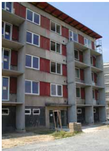
Izolované rozvody teplé vody a nově vybudované samonosné lodžie s minimalizací tepelných vazeb. Mezi lodžii a stěnou byl ponechán prostor 10 cm pro izolaci.
