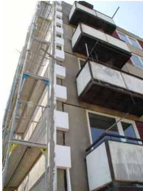
Stavební práce – nadstavba střechy (falešná atika), a izolování fasády polystyrénem 16 cm.
