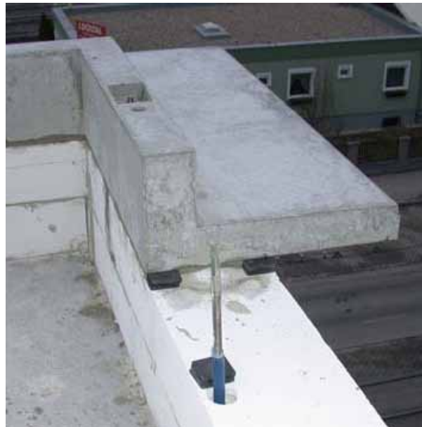
Obr. 13: Příklad tep.izolace atiky u konstrukce obrácené střechy (Zdroj Treiberspurg & Partner Architekten )
