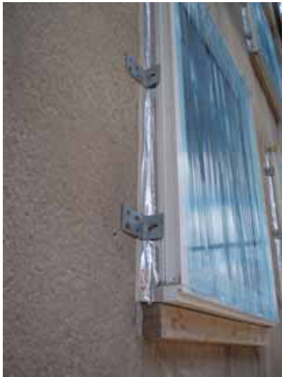
Obr. 14: Kotvení oken probíhá stejným způsobem jako u pasivních novostaveb. Okna jsou v ideálním případě předsazena až do vrstvy izolace kvůli eliminaci tepelných mostů. Důležité je také neprůvzdušné napojení rámu okna na konstrukci pomocí speciálních pásek nebo lišt. (Zdroj CPD, Solanova Consortium)
