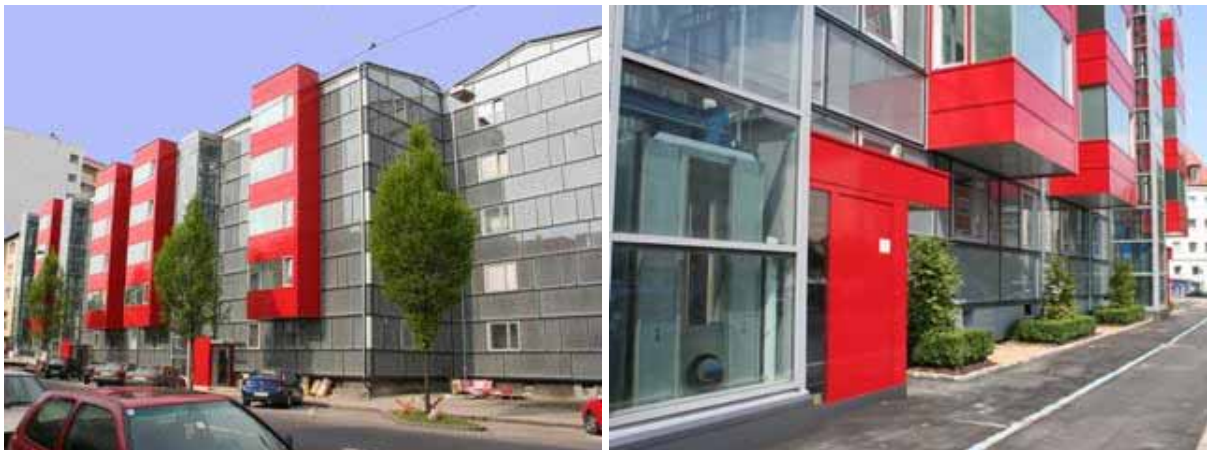
Stav po rekonstrukci
