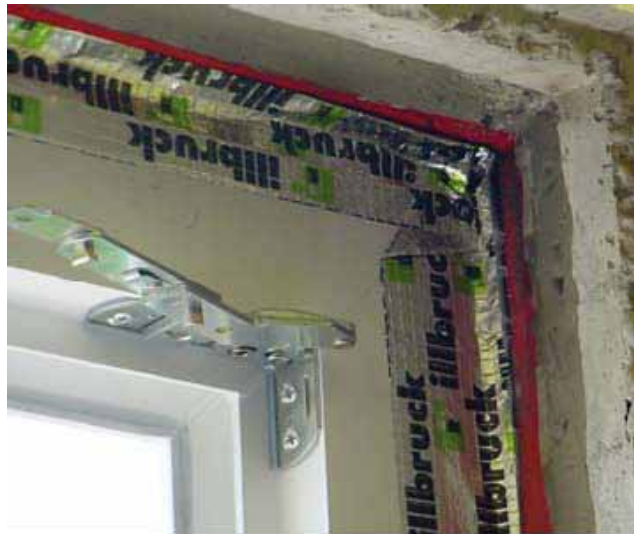
Obr. 14: Kotvení oken probíhá stejným způsobem jako u pasivních novostaveb. Okna jsou v ideálním případě předsazena až do vrstvy izolace kvůli eliminaci tepelných mostů. Důležité je také neprůvzdušné napojení rámu okna na konstrukci pomocí speciálních pásek nebo lišt. (Zdroj CPD, Solanova Consortium)
