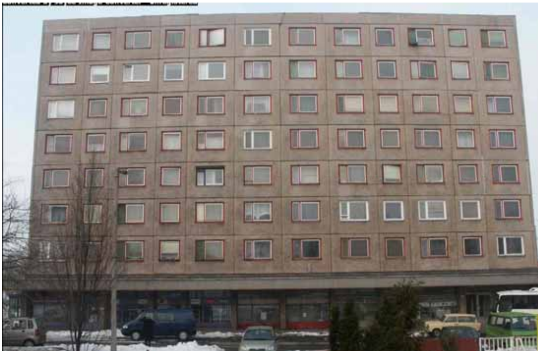
Před rekonstrukcí rok 2002.
