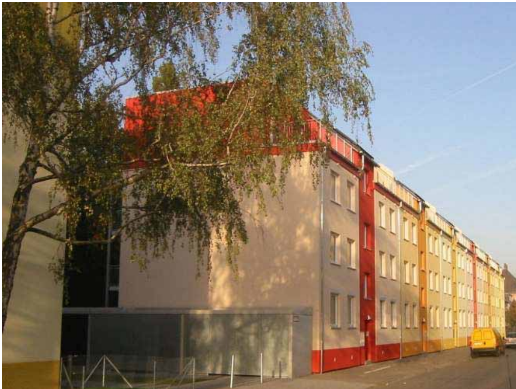
Obr 4: Po renovaci na pasivní standard - Projekt Tevesstrasse ve Frankfurtu (Německo). Roční spotřeba energie na vytápění 17 kWh/(m 2 a) dle výpočtu PHPP a spotřeba primární energie (pro vytápění, přípravu teplé vody a pomocnou energii) dle vyhlášky EnEV 37 kWh/(m 2 a). (zdroj Passivhaus Institut)
