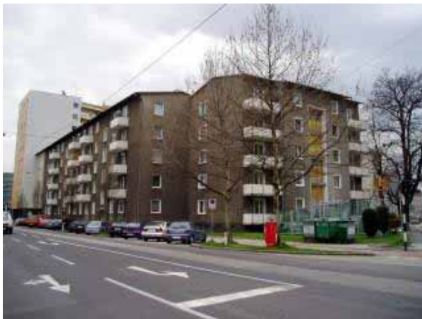
Původní stav před rekonstrukcí
