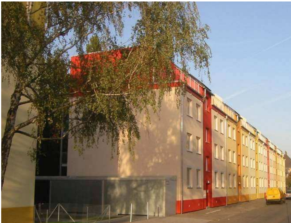
Abbildung 4: Nach der Sanierung - Projekt Tevesstraße in Frankfurt. Sanierung mit PH Komponenten. Jährlicher Heizwärmebedarf 17 kWh/(m²a) und Primärenergiebedarf (Warmwasser, Heizung und Hilfsstrom) 37 kWh/(m²a). Architekt – faktor 10, Darmstadt. (Quelle: PHI)
