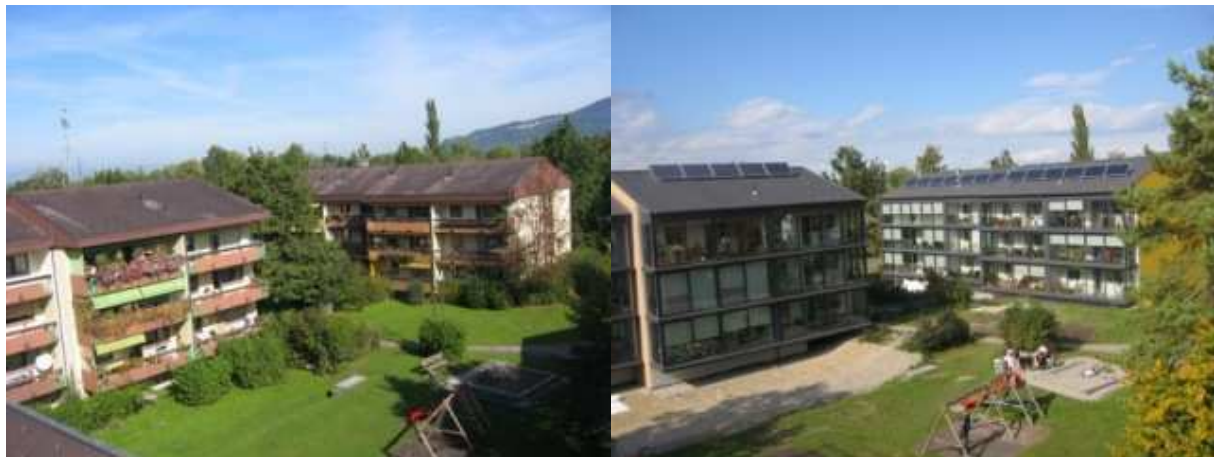
Abbildung 22: Altbausanierung Fussenau - Bestand und nach der Sanierung
