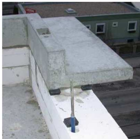
Abbildung 12: Beispiel einer Dämmung der Attika bei einem Umkehrdach (Quelle: Trebersprung & Partner Architekten)
