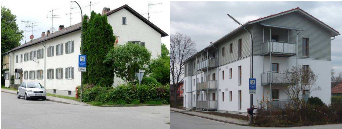
Abbildung 23: Altbausanierung Bruckmühl - Bestand und nach der Sanierung
