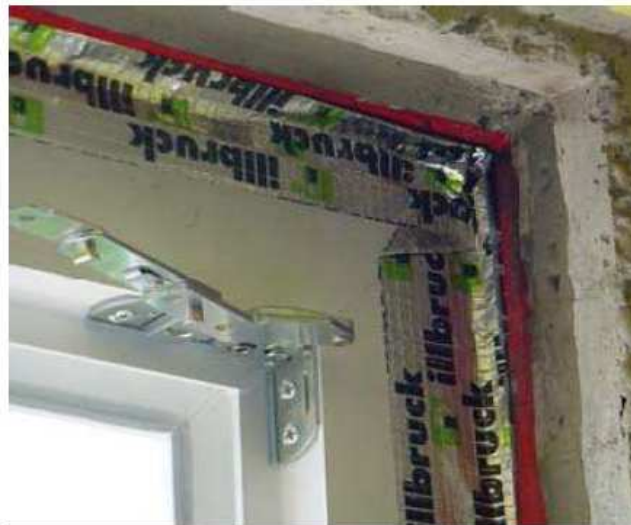
Abbildung 13: Die Fenstermontage ist die gleich wie in einem neuen Passivhaus. Die Fenster werden in die Dämmebene gesetzt um Wärmebrücken zu vermeiden. Der luftdichte Einbau durch spezielle Klebebänder und Dichtungsprofile ist ebenfalls sehr wichtig. (Quelle: CPD, Solanova Consortium)
