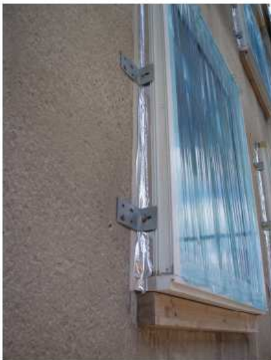
Abbildung 13: Die Fenstermontage ist die gleich wie in einem neuen Passivhaus. Die Fenster werden in die Dämmebene gesetzt um Wärmebrücken zu vermeiden. Der luftdichte Einbau durch spezielle Klebebänder und Dichtungsprofile ist ebenfalls sehr wichtig. (Quelle: CPD, Solanova Consortium)
