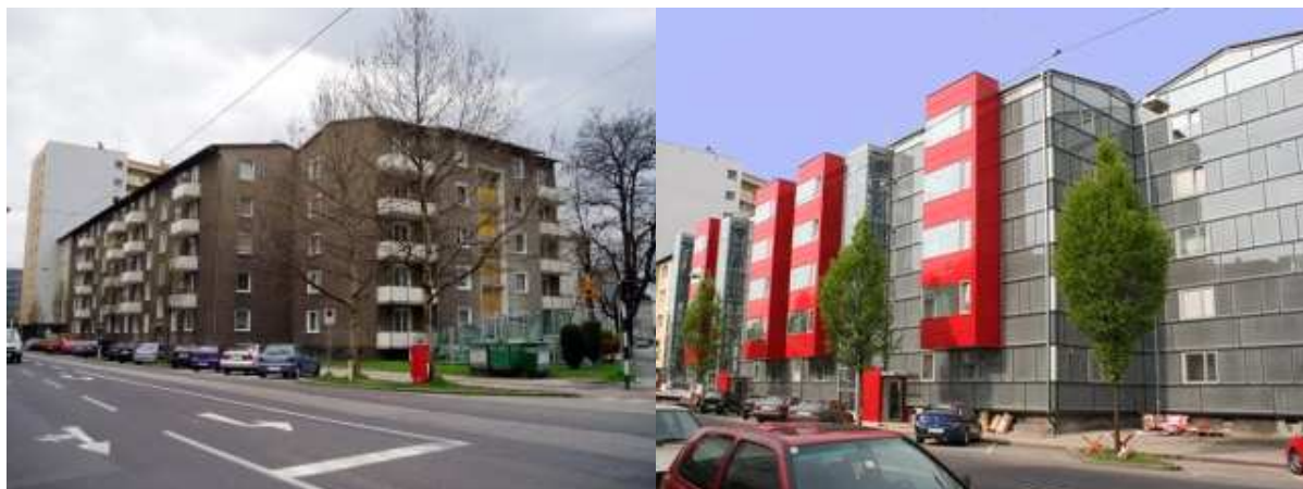
Abbildung 21: Altbausanierung Markatstraße - Bestand und nach der Sanierung
